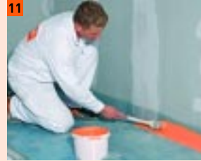
11 Płynną folię FERMACELL nanieść w narożach pędzlem
