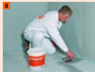
8 Spoiny i elementy mocujące szpachlować wg potrzeby
