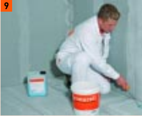
9 Gruntować gruntem FERMACELL najpierw na obrzeżach pomieszczenia...
