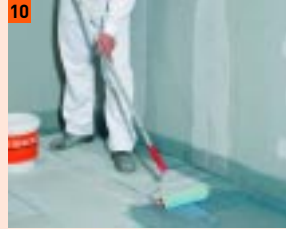
10 ... a następnie wałkiem na powierzchni całej podłogi
