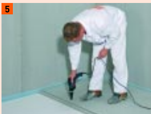
5 Stosować: wkręty samogwintujące Powerpanel...
