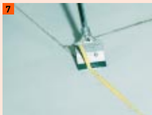
7 Nadmiar kleju do jastrychów ściąć po wyschnięciu
