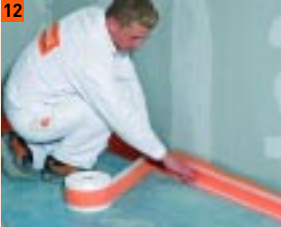
12 Na mokrą folię docisnąć taśmę uszczelniającą
