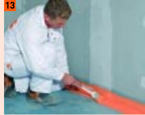
13 W drugim cyklu roboczym pokryć taśmę uszczelniającą płynną folią FERMACELL
