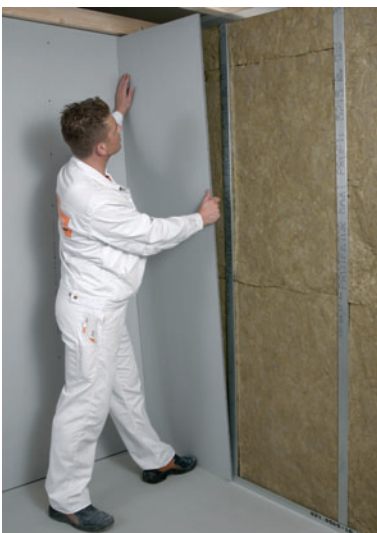
Montaż płyty
